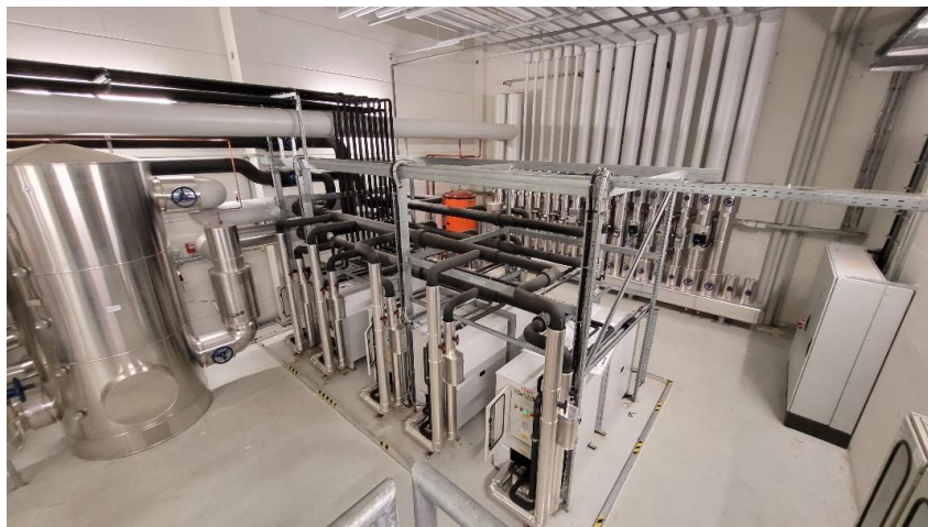
Abbildung 2: Heizzentrale/Anordnung der Hydraulikmodule
